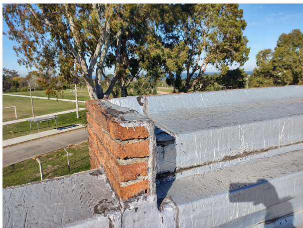
PRETILES REVESTIDOS CON LADRILLO VISTO
